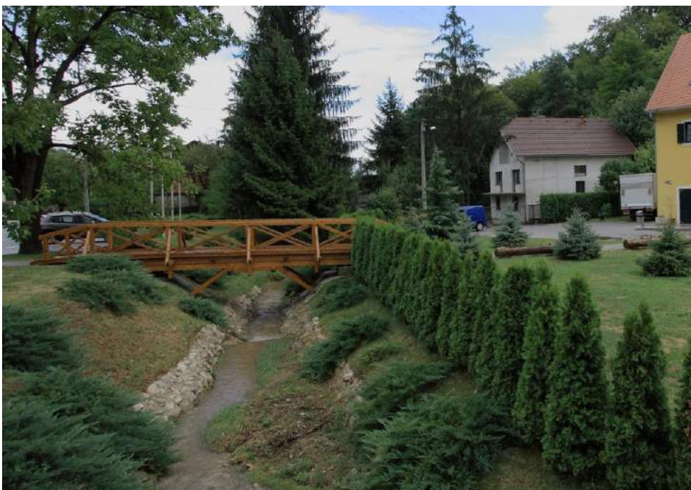
Slika 15. Vodotok Zelina oko 750 m uzvodno od lokacije zahvata u sjevernom dijelu naselja Biškupec Zelinski
